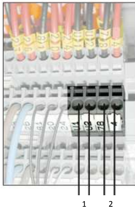
Figura 3.4: Esempio morsettiera utente
